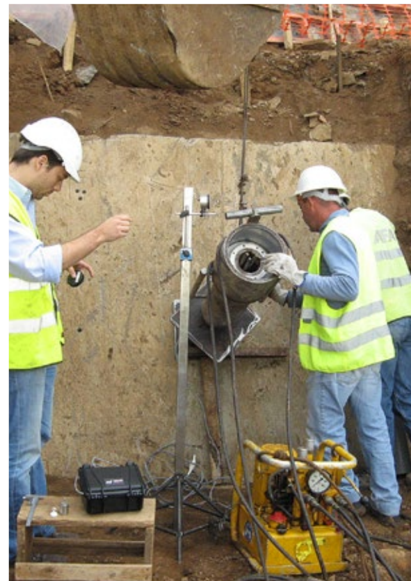
Bomba e Cilindro Hidráulico de Pré-esforço
